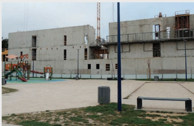
Sur 2 niveaux au-dessus du rez-de-chaussée, l'aile principale abritera 10 salles de classes élémentaires.
