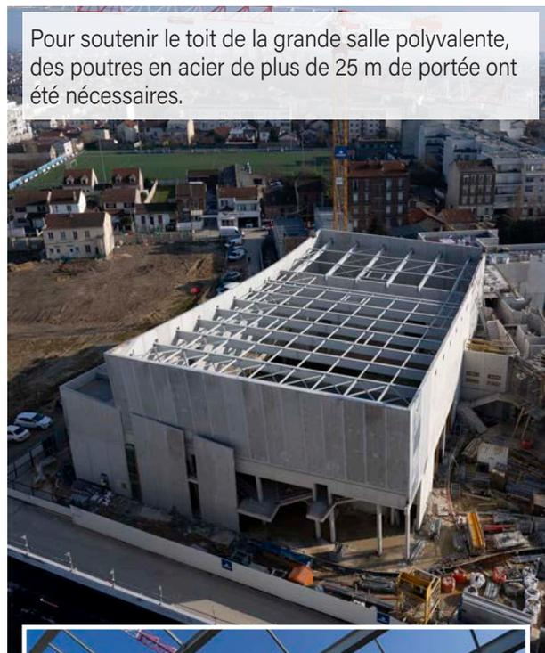
Pour soutenir le toit de la grande salle polyvalente, des poutres en acier de plus de 25 m de portée ont été nécessaires.
