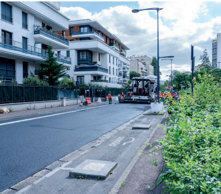
Planning serré, le 22 août ! 500 mètres d'enrobé à poser en moins de 10 h, rue Blanqui. Contrainte : limiter la fermeture d'un axe majeur. La rénovation, rendue nécessaire par la circulation intense et le passage du bus 151, a aussi permis au réseau cyclable drancéen de s'étendre : les itinéraires vélo des rues Jacqueline Quatremaire et Bois de Groslay sont désormais connectés à l'avenue Henri Barbusse, où on attend que le département, responsable de cette voie, crée enfin sa "piste verte".
