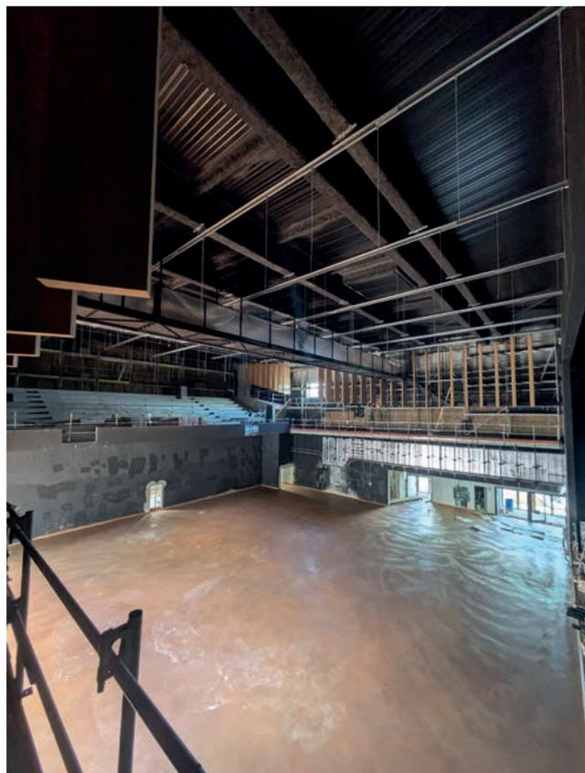
Dans la grande salle de spectacle, le ponçage va bientôt débuter avant que les rangées de fauteuils rétractables ne soient installées.
