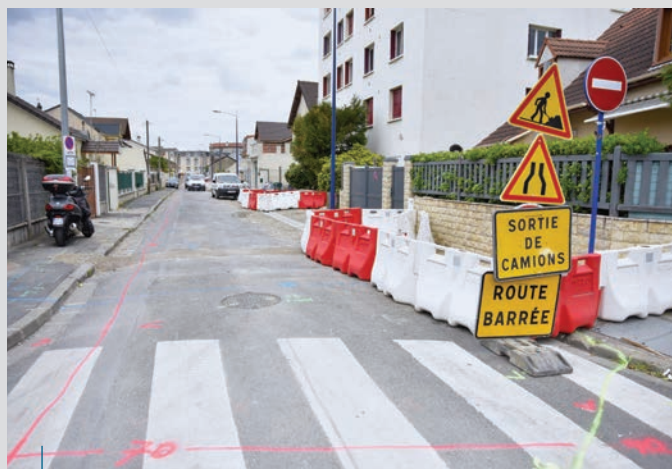
Quartier Drancy centre. Démarrés mi-avril, les travaux de réfection de la rue du Noyer Bondon devraient durer 4 mois. Coût : 360 000 €.
