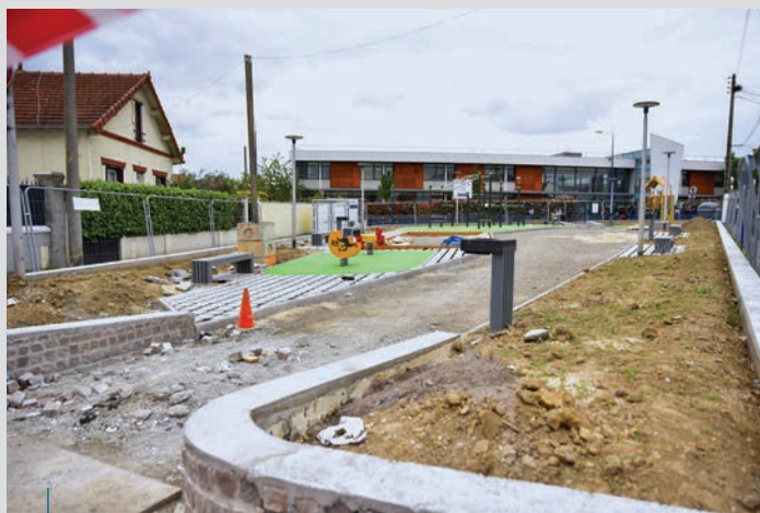
Quartier Drancy centre, le square situé entre les rues Charles Gide et Max Jacob, en face du collège Paul Bert, est en train d'être totalement réaménagé. La fin des travaux est prévue fin mai. Coût : 237 450 €.
