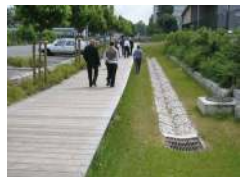
Noue de stockage à Clichy-sous-Bois
