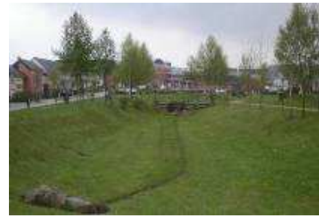
Bassin d'infiltration enherbé
