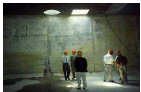
Bassin enterré visitable
